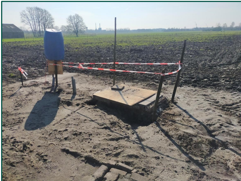
Nutsvoorzieningen zijn al op het perceel aanwezig
